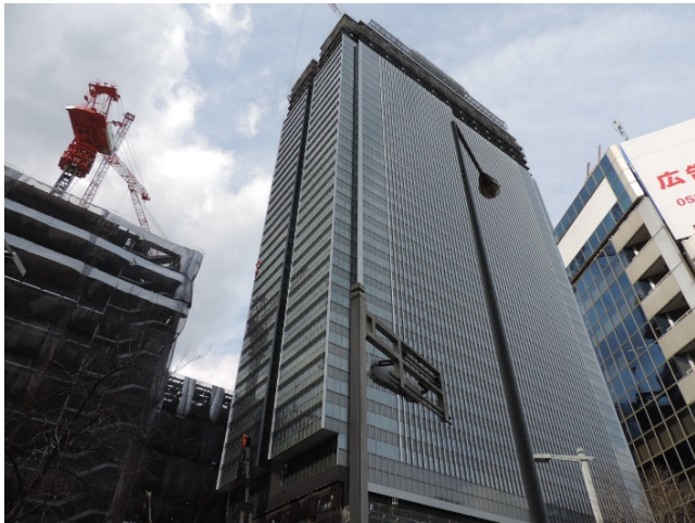
(東側から見た工事中の JP タワー名古屋)
