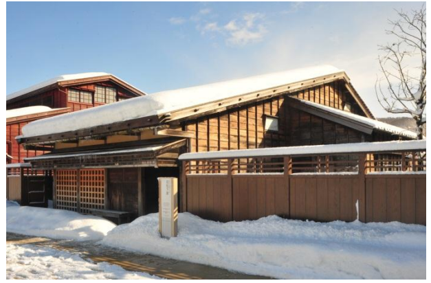
〔図15・16〕 重要文化財 旧松下家住宅 (金沢市) 19世紀中頃
