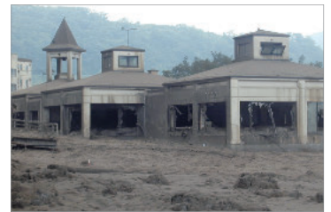
有珠山の泥流（平成12年6月14日撮影） Structures damaged by mudflow of Usuzan (14 Jun 2000)
