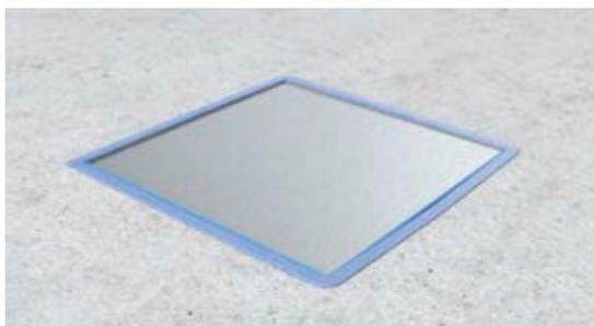
Bodendose, nachdem die Dämmung, die Bodenheizung und der Unterlagsboden eingegossen worden ist.
