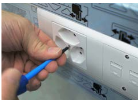
Befestigung der Zentralscheibe und Blende, bevor ganz zum Schluss die Schutzfolie entfernt wird.
