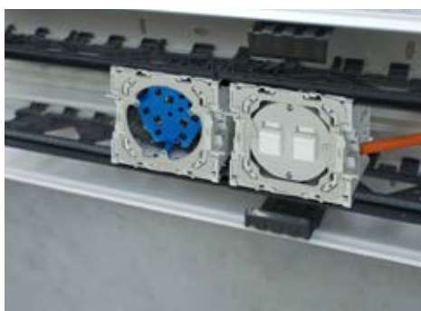
Schraublose Befestigung von Steck-/Datendosen
