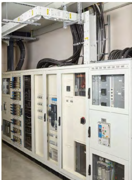
Anbindung unibar H an unimes H (Beispiel)
