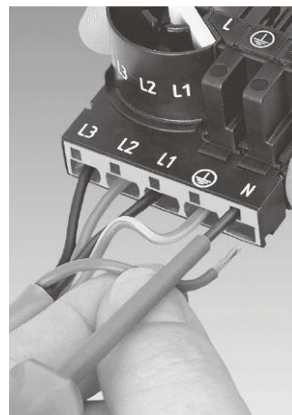
Aderisolatie over 9 mm verwijderen. Klem openen met Quicky schroevendraaier en draad insteken; Quicky verwijderen. Inklemming controleren door aan de draden te trekken.
