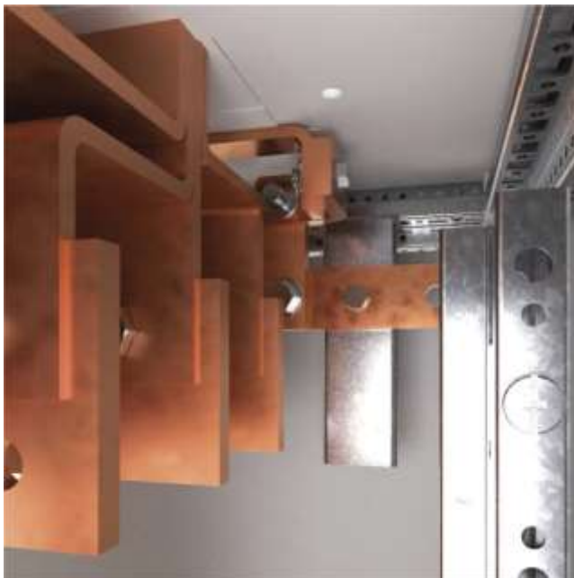
PE-aansluiting
