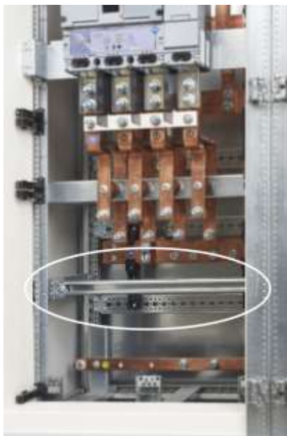
Kabelopvangrail (kabel niet afgebeeld)
