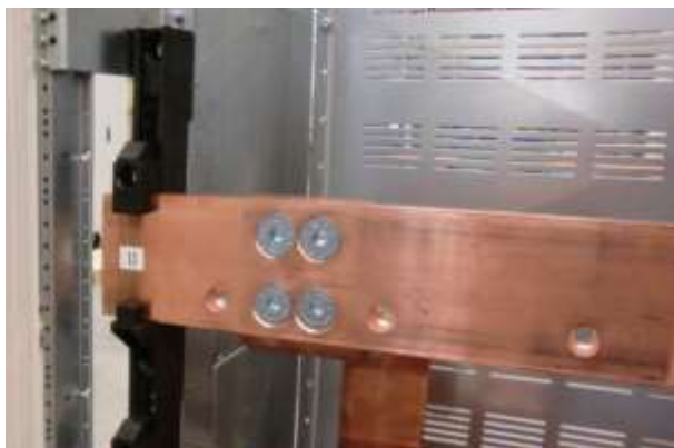
Invoer 185 mm railsysteem
