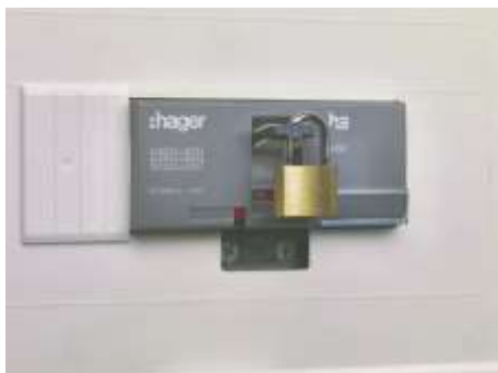
S014, hangslot voor draaischakelaar
