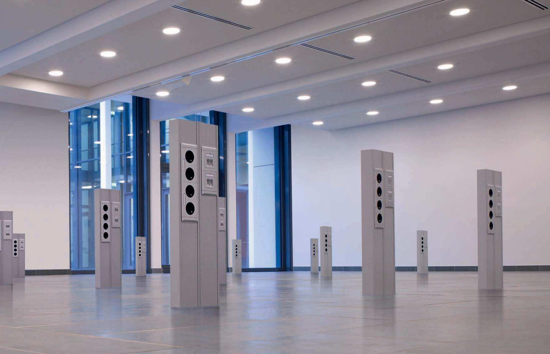
Projektlösung für einen Multifunktionsraum: zweizügiges BR Profil aus Stahlblech mit Energie- und Datenanschlüssen als in den Boden einklappbare Energie- und Datensäule mit Bodenbelag auf der Verschlussplatte.
