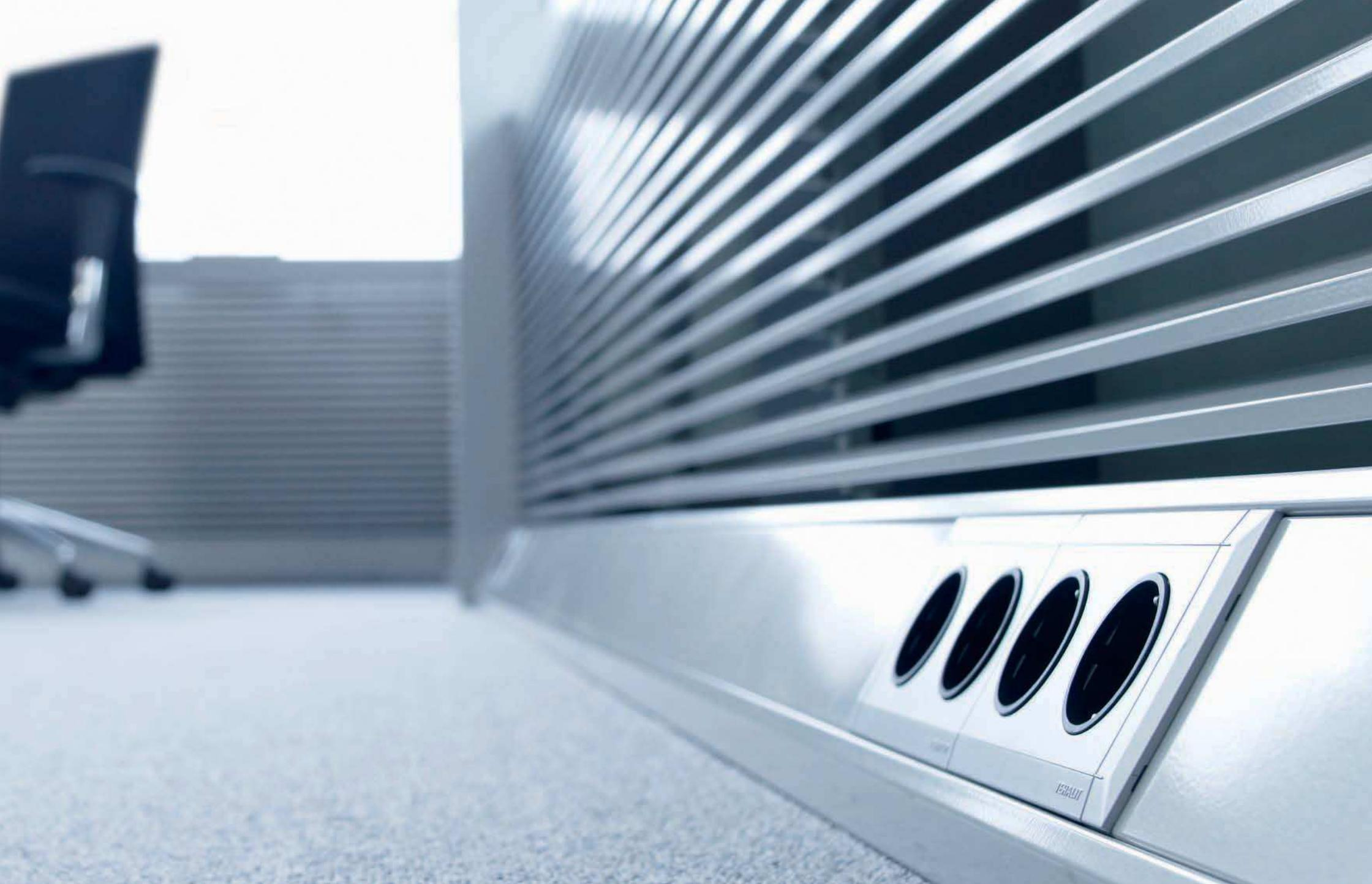
Die Dreiecksform des BR Profils aus Stahlblech bildet den sauberen Abschluss am Boden, benötigt wenig Raum und erleichtert den Zugriff auf die Einbaugeräte.
