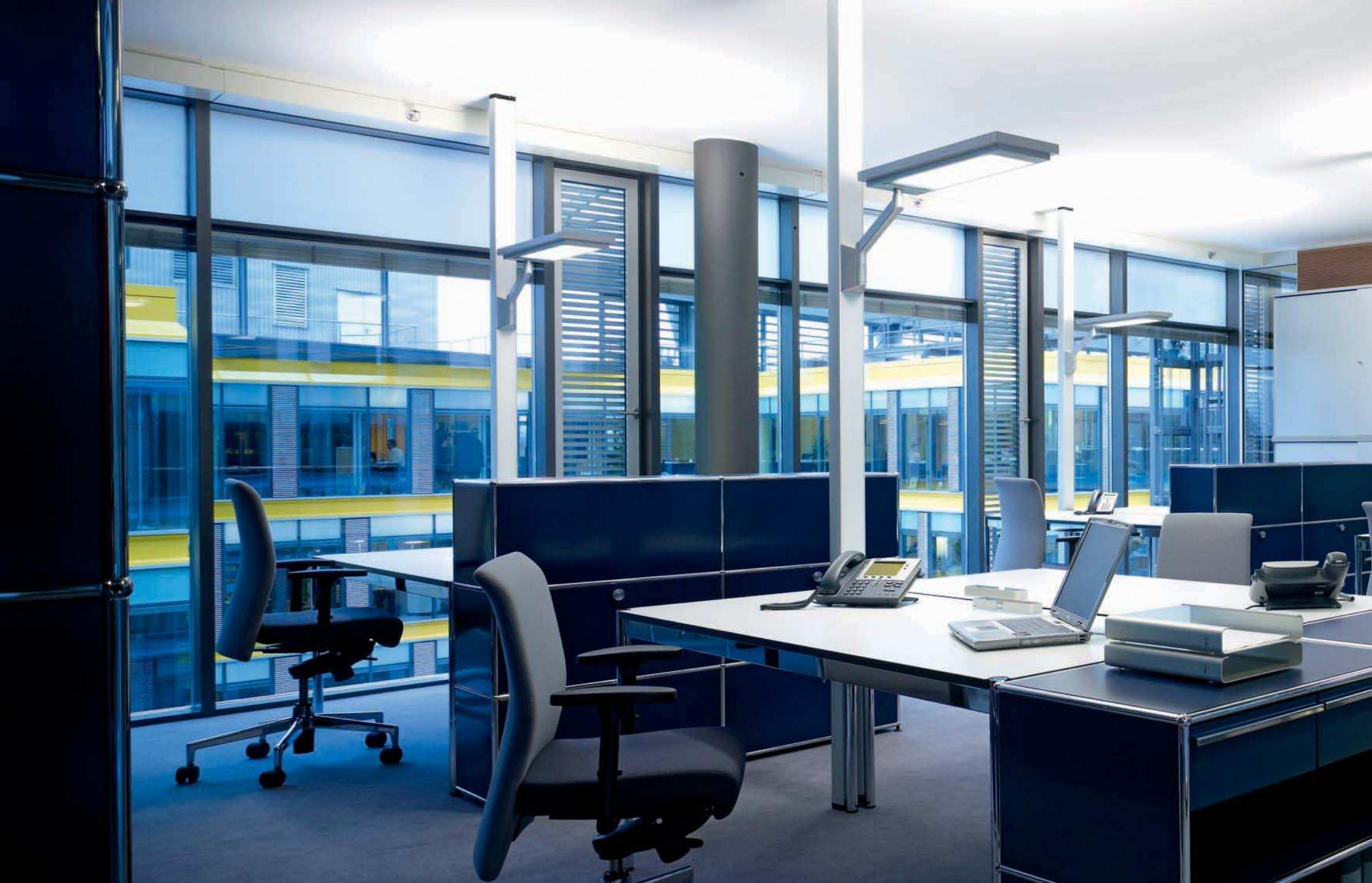
Projektlösung: Deckenanschlusssäulen DA 200 aus Aluminium, die die benötigten Anschlüsse für Energie und Daten sowie die Arbeitsplatzbeleuchtung direkt an die Schreibtische bringen. Leuchten: Waldmann.
