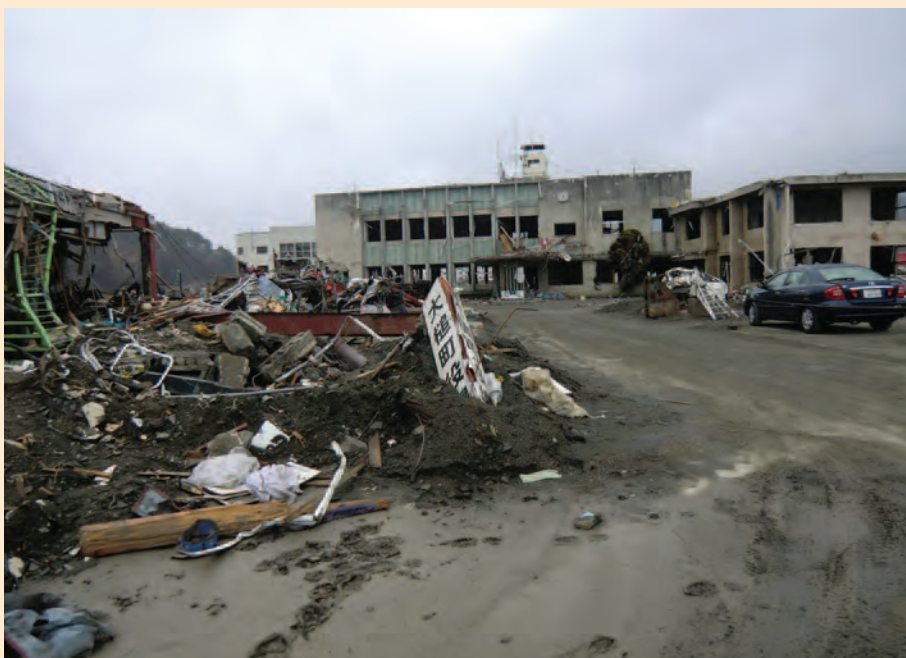
図1：津波で損壊した大槌町役場
