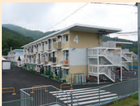
図6（左）：仮設住宅の改善～断熱材と二重窓ガラスを追加 図7（右）：コンテナを積み重ねて建設された複数階仮設住宅
