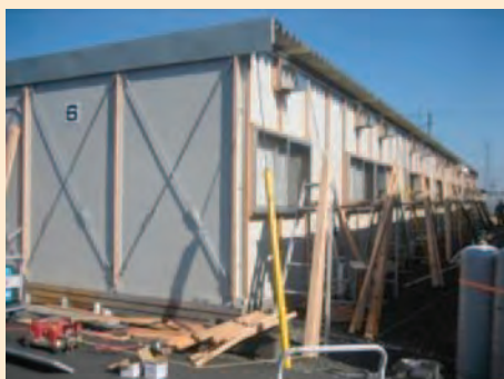
図6（左）：仮設住宅の改善～断熱材と二重窓ガラスを追加 図7（右）：コンテナを積み重ねて建設された複数階仮設住宅
