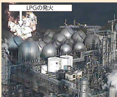
図5：精油所で漏出したLPGの発火
