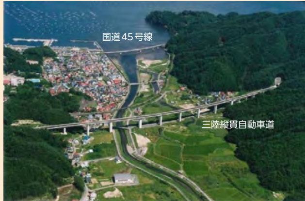
図2：三陸縦貫自動車道。津波を念頭に置いて建設された道路
