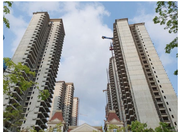
建設中のマンション＝5月1日、中国広西チワン族自治区南寧市
