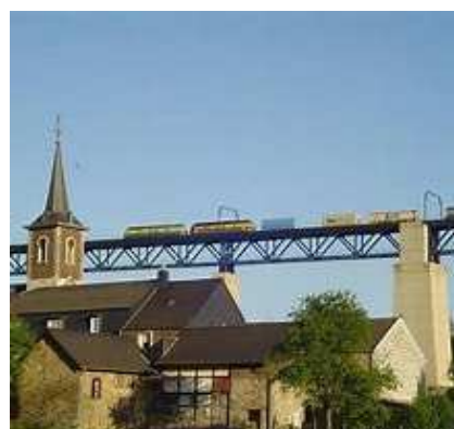
Viadukto de Moresnet
