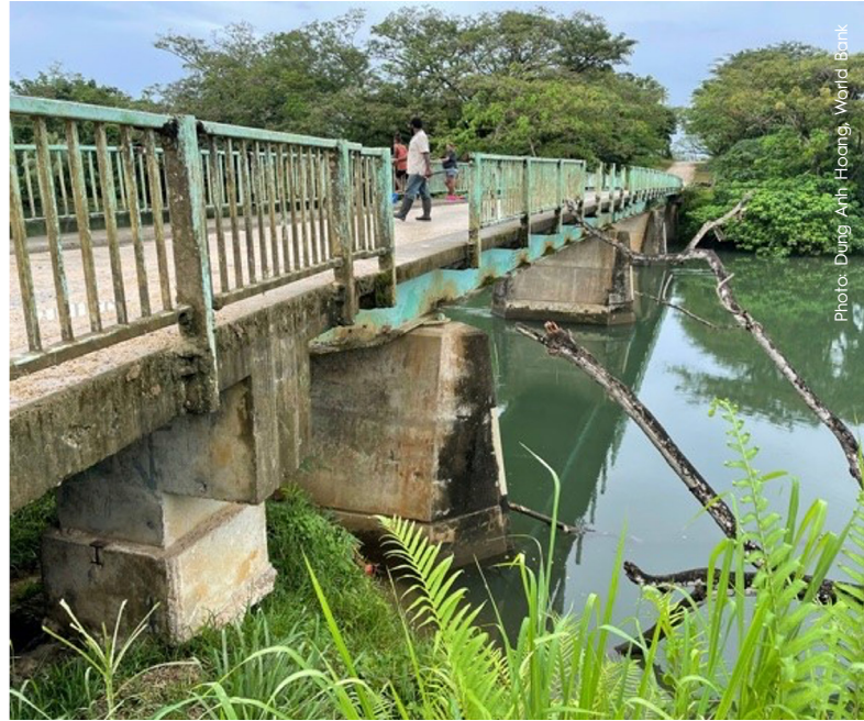
バヌアツ共和国のサウス・サント・ロードの橋 ©ドン・アン・ホアン / 世界銀行
