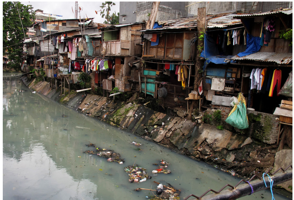
ジャカルタの水路の復旧による洪水リスクの軽減
