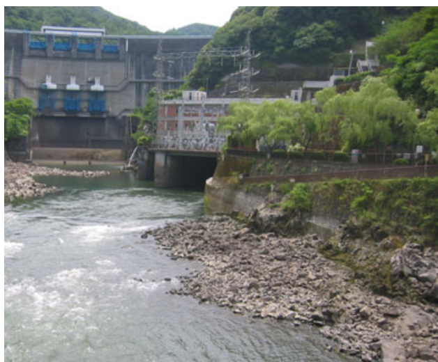
写真 1.3-1 天ヶ瀬ダムおよび天ヶ瀬発電所概観
