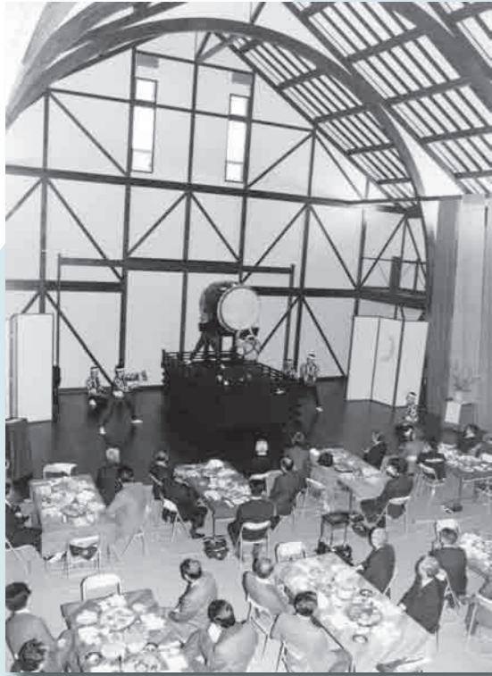
3月21日、稽古場棟竣工式。「太鼓」と「三宅」を演奏 (設計：TEM 研究所 / 建築棟梁：佐藤正) (内藤隆)
