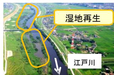
(国土交通省) 高水敷掘削による湿地再生
