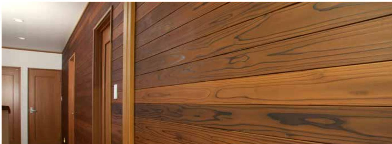
ムクの木を内装部材として使用する場合に問題となりがちな施工後の隙間や狂いは、湿度の変化による「木」の伸縮に起因しています。極めて低い含水率を維持できるエステックウッドはこの伸縮がとて少ないので、特に温度差の激しい環境で高いパフォーマンスを発揮します。また、製造工程において化学薬品は一切使用しておりませんので、「木」同様に安心してご使用いただけます。
